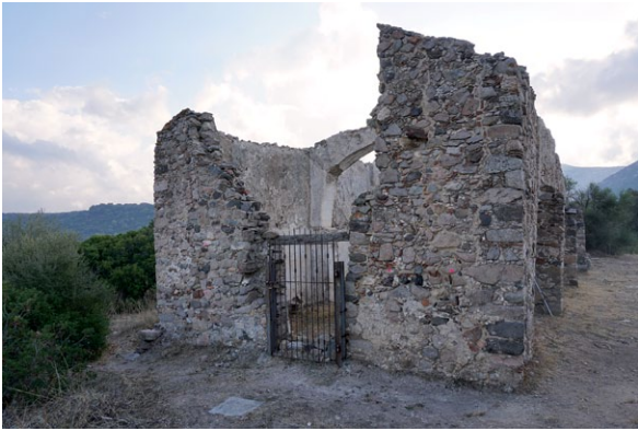
Fig. 59. Chiesa di Santa Lucia, paramento esterno della facciata.
