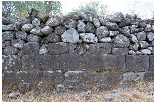
Fig. 58. Chiesa di Iloghe, paramento esterno del muro perimetrale settentrionale.
